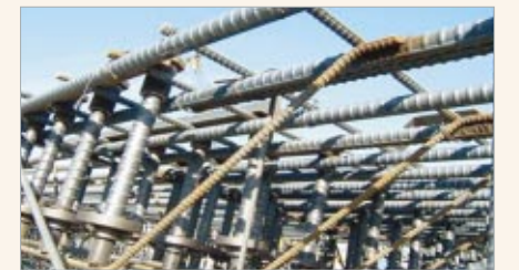
외부 옹벽 수평 전단보강근
