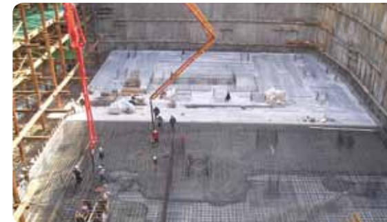
Bugok Prugio site
