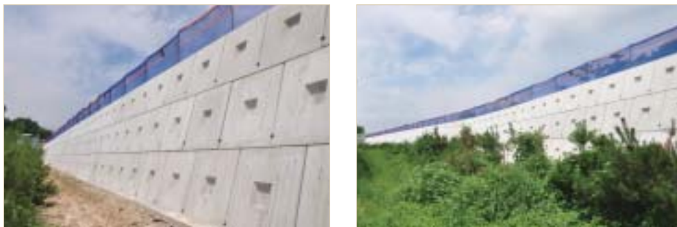
그림 3 PMR 옹벽 시공전경서운~안성간 도로확·포장공사 구간
