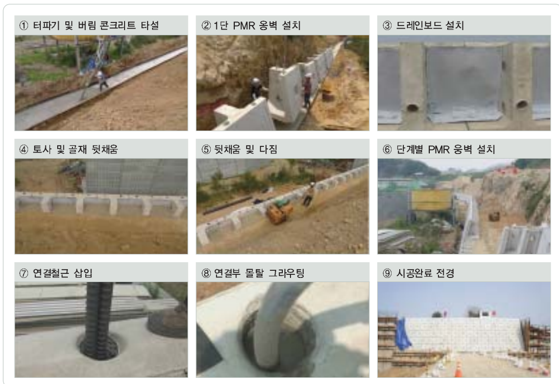
그림 2 PMR 옹벽 시공순서
