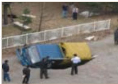
그림 1 다짐불량 및 토사유실로 인한 각종 사고
